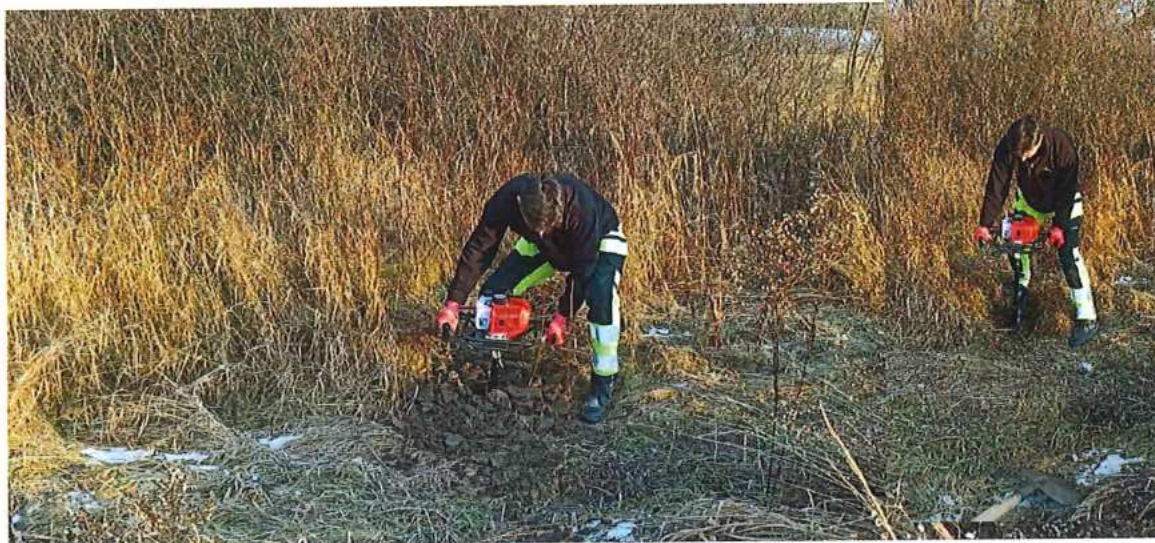
obr. 4 , DNV(mimo) - Malacky, stabilizácia pažnice - neprístupný terén pre vrtnú súpravu
